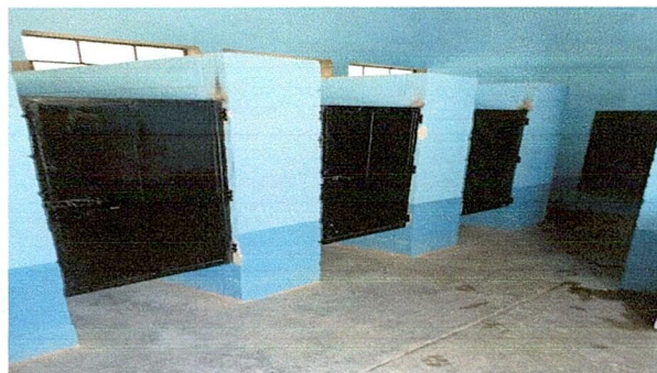
Foto 1: En esta imagen nos muestra la finalización de instalaciones de puertas y tazas de los servicios sanitarios.
