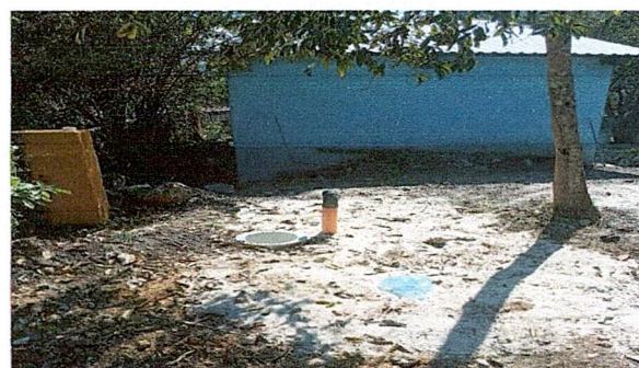
Foto 4: Imagen que nos muestra el lugar en donde se ha finalizado la instalación del Biodigestor, junto al pozo de absorción para las aguas negras y grises de la descarga de los servicios sanitarios.
